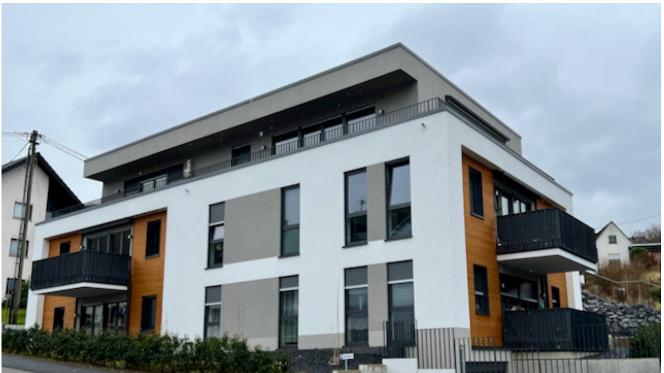
Blick von der Straße
